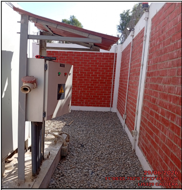
Foto Panorámica del Interior del Site
