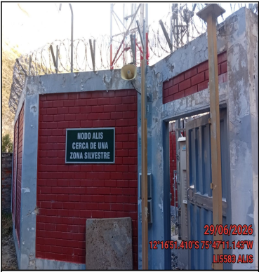
Pozo a tierra
