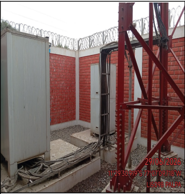
Foto Panorámica del Interior del Site
