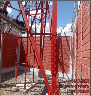
Foto Panorámica del Interior del Site
