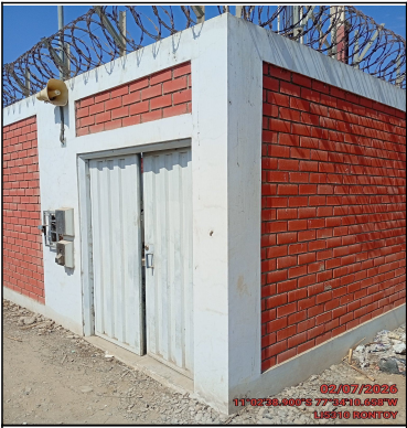
Pozo a tierra
