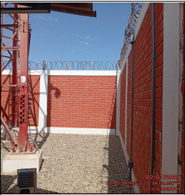
Foto Panorámica del Interior del Site
