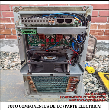
FOTO COMPONENTES DE UC (PARTE ELECTRICA)
