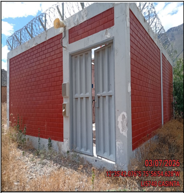
Pozo a tierra
