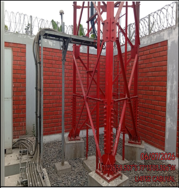
Foto Panorámica del Interior del Site
