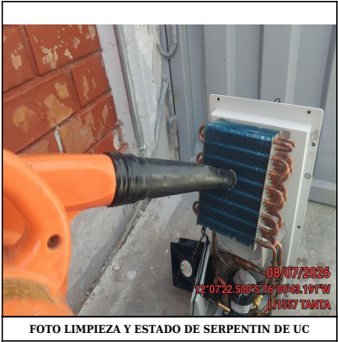
FOTO LIMPIEZA Y ESTADO DE SERPENTIN DE UC
