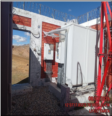
Foto Panorámica del Interior del Site
