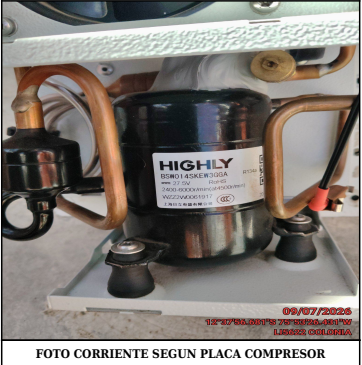
FOTO CORRIENTE SEGUN PLACA COMPRESOR
