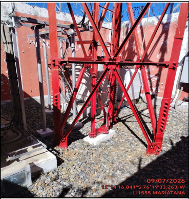
Foto Panorámica del Interior del Site
