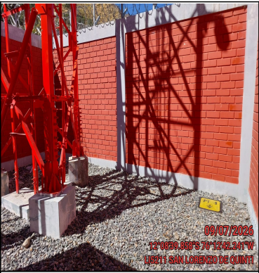
Foto Panorámica del Interior del Site
