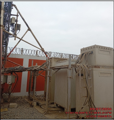
Foto Panorámica del Interior del Site
