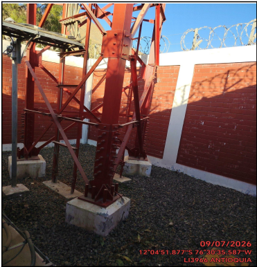
Foto Panorámica del Interior del Site
