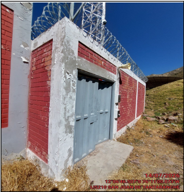
Pozo a tierra
