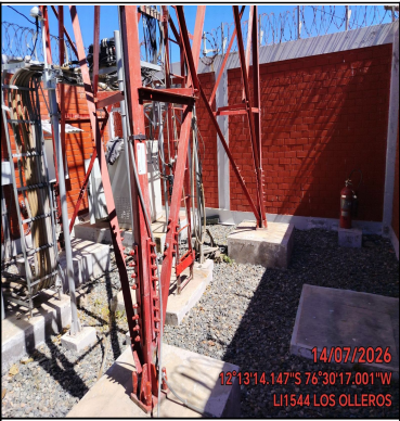
Foto Panorámica del Interior del Site
