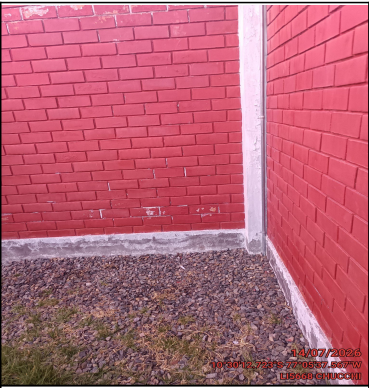
Foto Panorámica del Interior del Site
