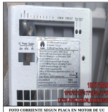
FOTO CORRIENTE SEGUN PLACA EN MOTOR DE UC
