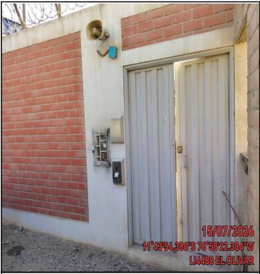
Pozo a tierra
