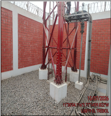
Foto Panorámica del Interior del Site
