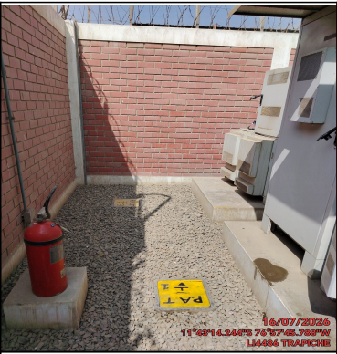
Foto Panorámica del Interior del Site
