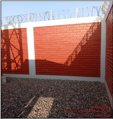
Foto Panorámica del Interior del Site
