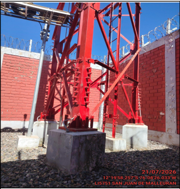
Foto Panorámica del Interior del Site
