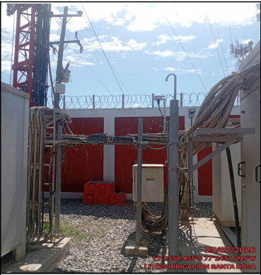
Foto Panorámica del Interior del Site
