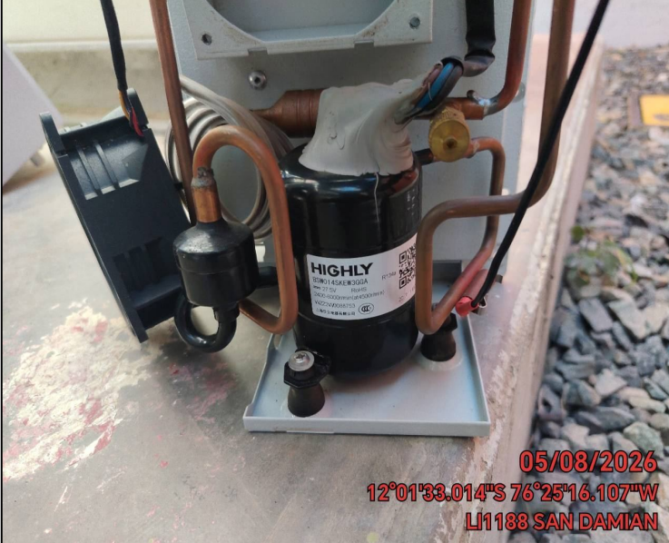
FOTO 8: REVISIÓN DEL COMPRESOR
