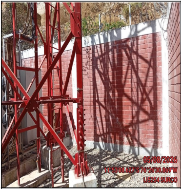
Foto Panorámica del Interior del Site
