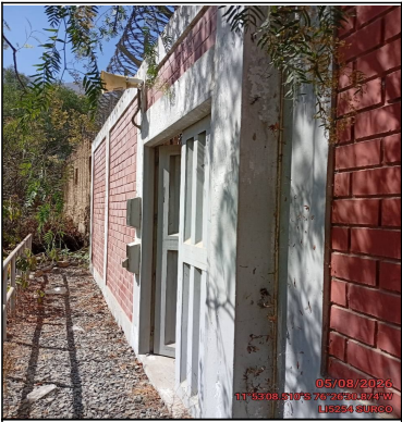
Pozo a tierra
