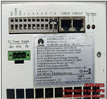
FOTO DE PLACA DE UNIDAD EVAPORADORA
