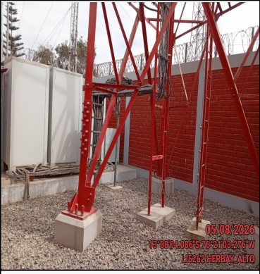
Foto Panorámica del Interior del Site
