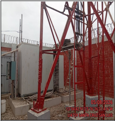
Foto Panorámica del Interior del Site
