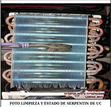
FOTO LIMPIEZA Y ESTADO DE SERPENTIN DE UC
