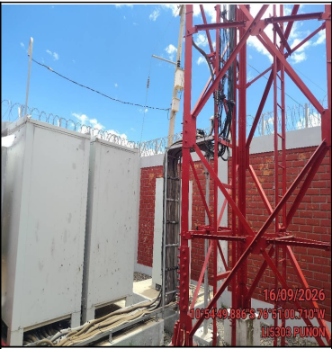
Foto Panorámica del Interior del Site
